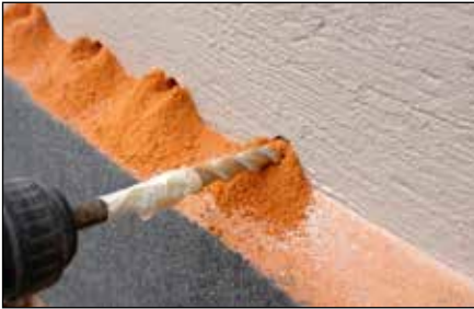
Boreddybden kan markeres med malertape.
