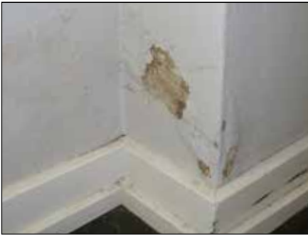
Løst puds/maling/tapet, fodlister, radiatorer m.m. fjernes i det fugtskadede område.
