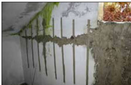
Sætningsrevner udbedres med Skalflex Armérstål og Skalflex Multipuds. Se udførlig vejledning på side 19.
