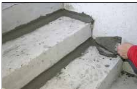
E Trinene genetableres med Skalflex Reparationsbeton Vandtæt. Der laves fald på træde trinene, og der laves hældning på stødtrinene. Der laves hulkehl mod facade og mellem stød- og træde trin.
