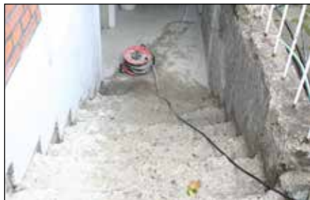
Træde trin og stødtrin m.m. ruhugges ned til fast beton.
