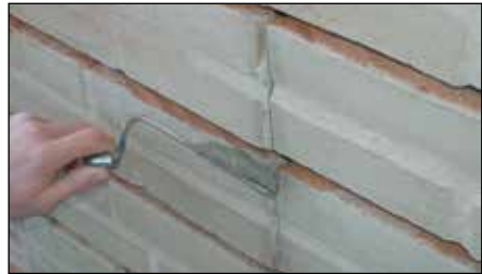
Skalflex Multipuds trykkes ind i fugen i ca. 1 cm tykkelse.
