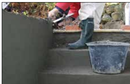
F Trin og stødtrin armeres med Skalflex Pansernet, som arbejdes ned i pudslaget med pudsebræt. Anvend panserhjørneprofil på trinenes forkant.
